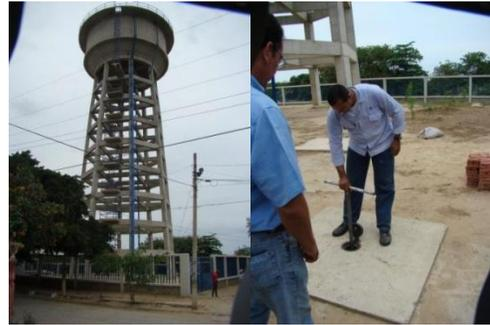
Tanque del El Concord, en la cabecera sur del aeropuerto Ernesto Cortizos.  $V=700 \text{ m}^3$ ,  $H=30 \text{ m}$  (al fondo). Trabaja para garantizar presiones en el sistema. Desde allí se controla el abastecimiento a los diferentes sectores.
